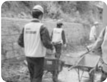
がれきの撤去作業をしています
